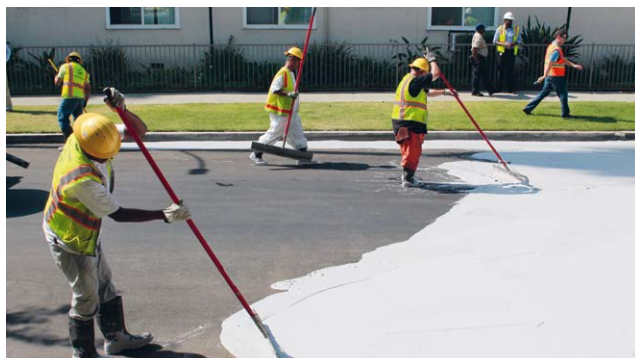
Fig. 82 : Repeindre une rue avec un enduit réfléchissant permet de réduire la chaleur qu'elle restitue – Le projet pilote « Cool Pavement » à Los Angeles
